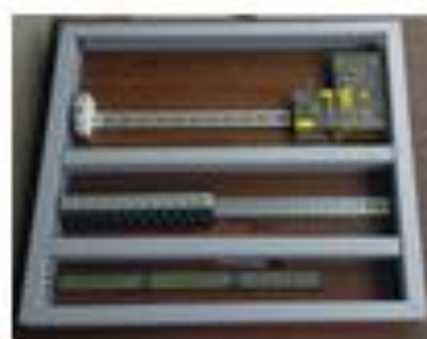
Gambar 4. Pemasangan Duct
