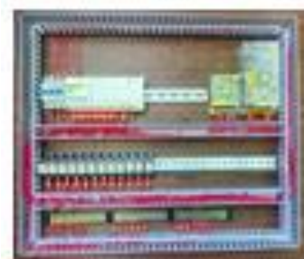
Gambar 5. Pemasangan Wiring Kabel
