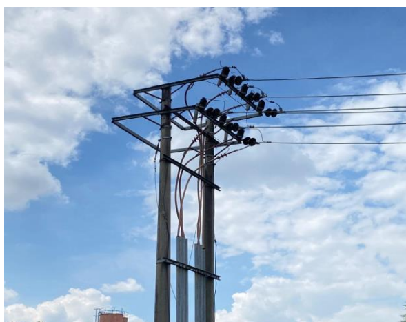
Gambar 5. Tiang SUTM Penyulang Jelutung
