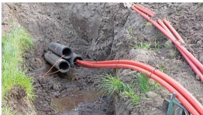
Gambar 3. Saluran Listrik Bawah Tanah.
